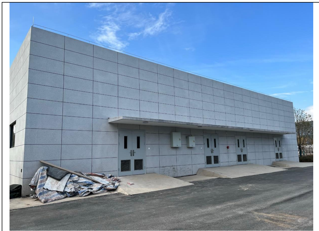
项目区建筑物（2023年12月）
